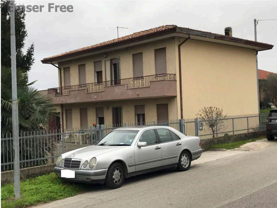
4 - Vista del fabbricato da via Cà Brazzo
