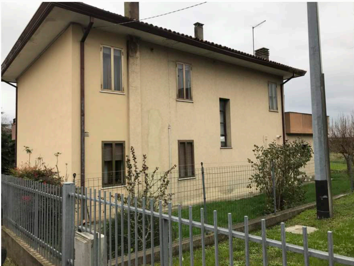
5 - Vista del fabbricato da via Cà Brazzo
