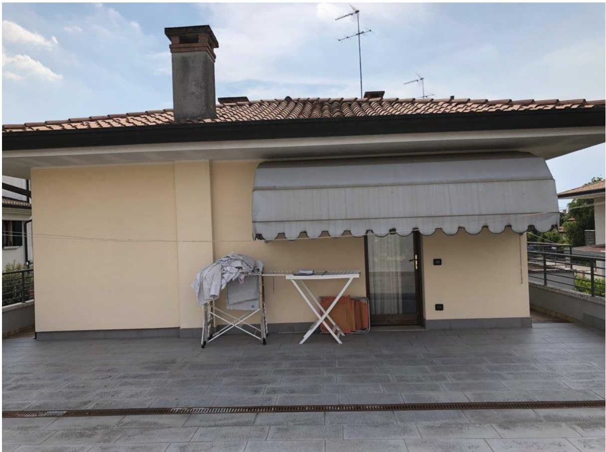
foto n. 16 – terrazza a piano primo
