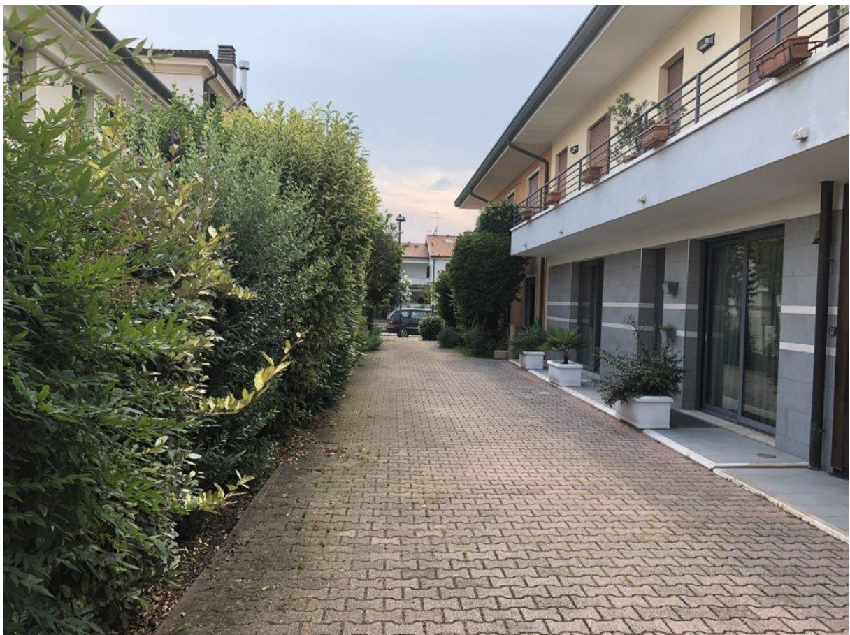
foto n. 6 – cortile comune (sub. 13) e facciata sud dell'appartamento pignorato
