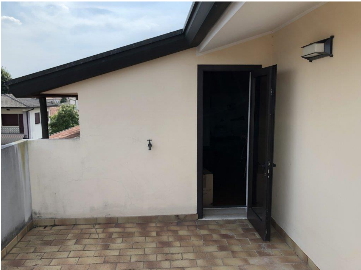
foto n. 22 – terrazza a piano secondo
