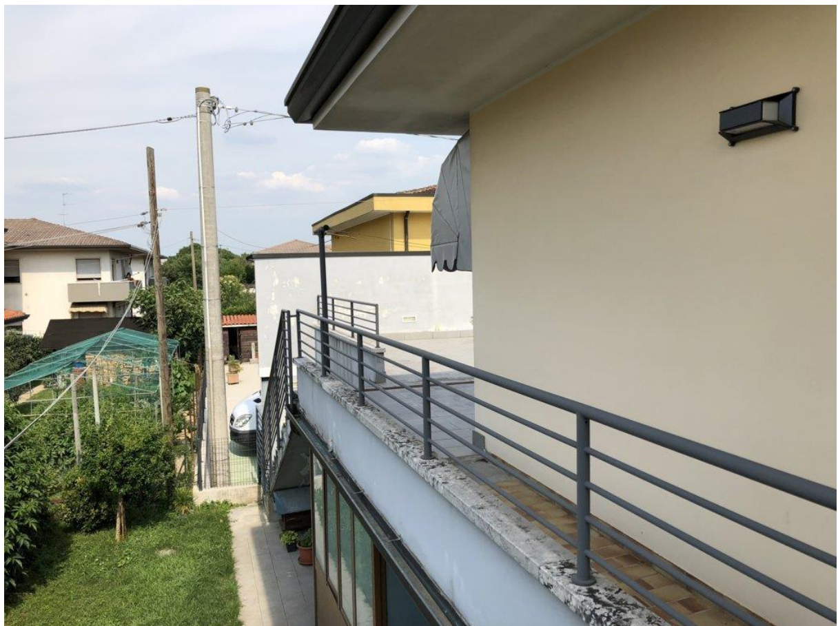
foto n. 18 – poggiolo piano primo lato nord
