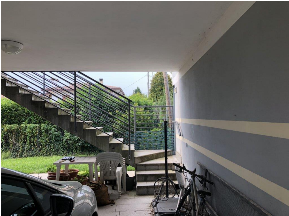
foto n. 27 – garage pignorato (sub. 24) e scala esterna
