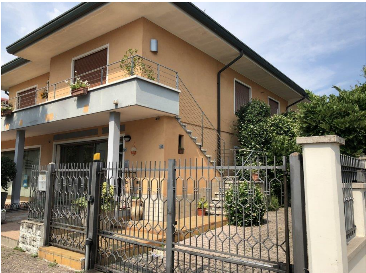
foto n. 2 – angolo sud-ovest del fabbricato
