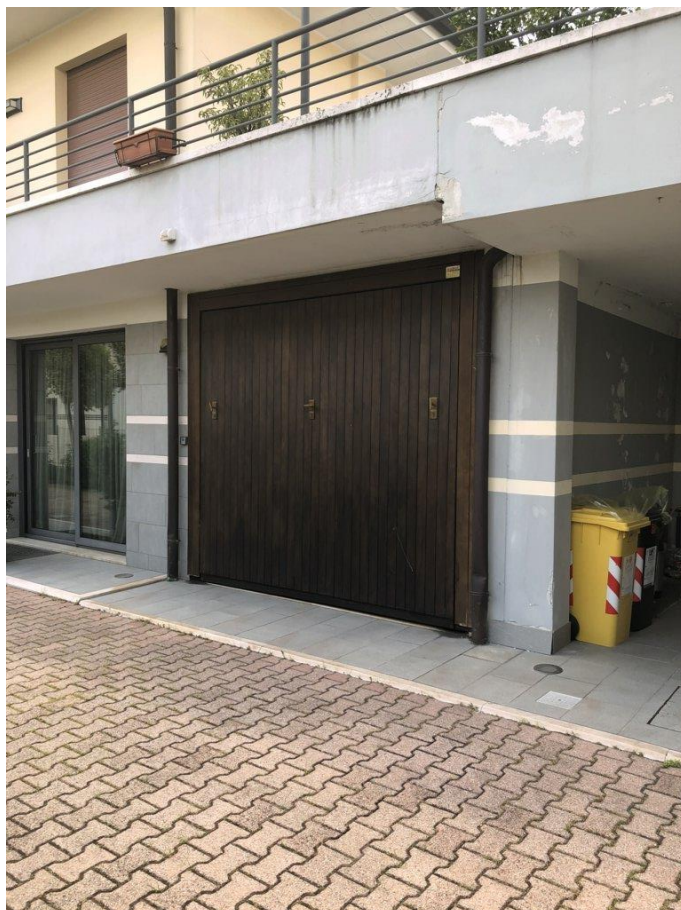
foto n. 25 – garage pignorato (sub. 22)
