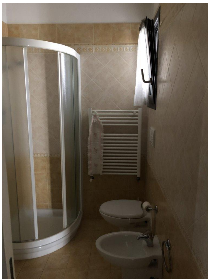
foto n. 10 – bagno a piano terra
