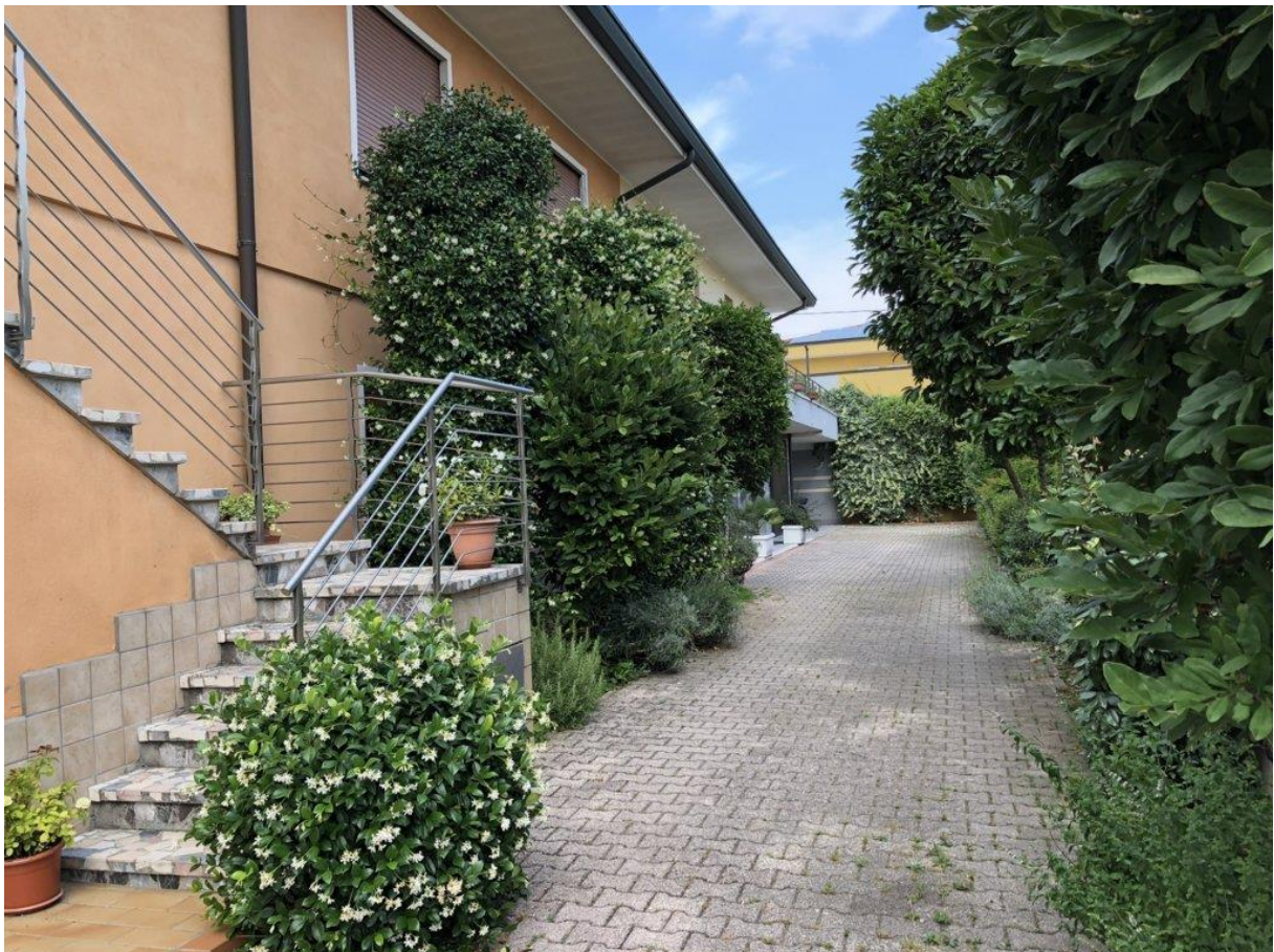
foto n. 4 – cortile comune (sub. 13)
